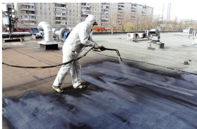
Нанесение жидкой резины на кровлю
